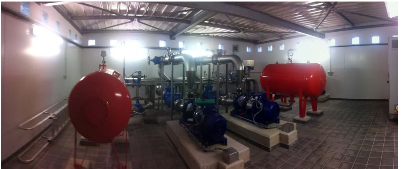
Station d'interconnexion Equipement intérieur
