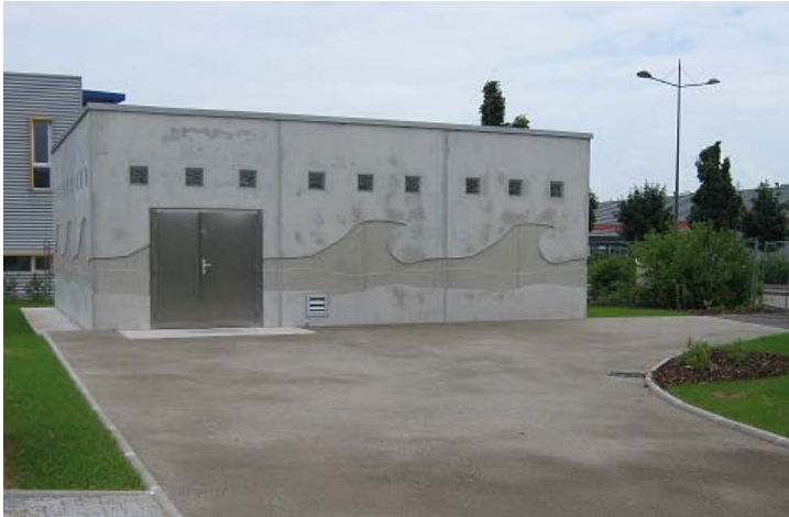
Station d'interconnexion Vue extérieure
