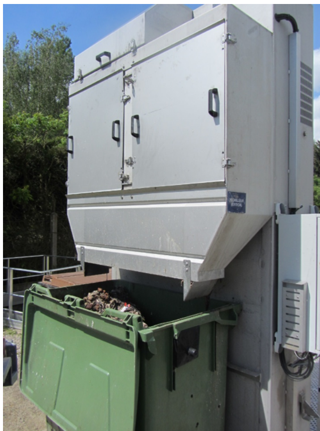
Station d'épuration de Molsheim Installation d'un nouveau dégrilleur grossier en tête de station
